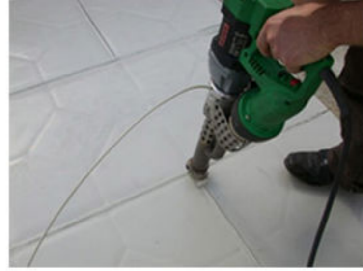
EKSTRÜZYON KAYNAĞI İLE SIZDIRMAZLIK SAĞLANIR
